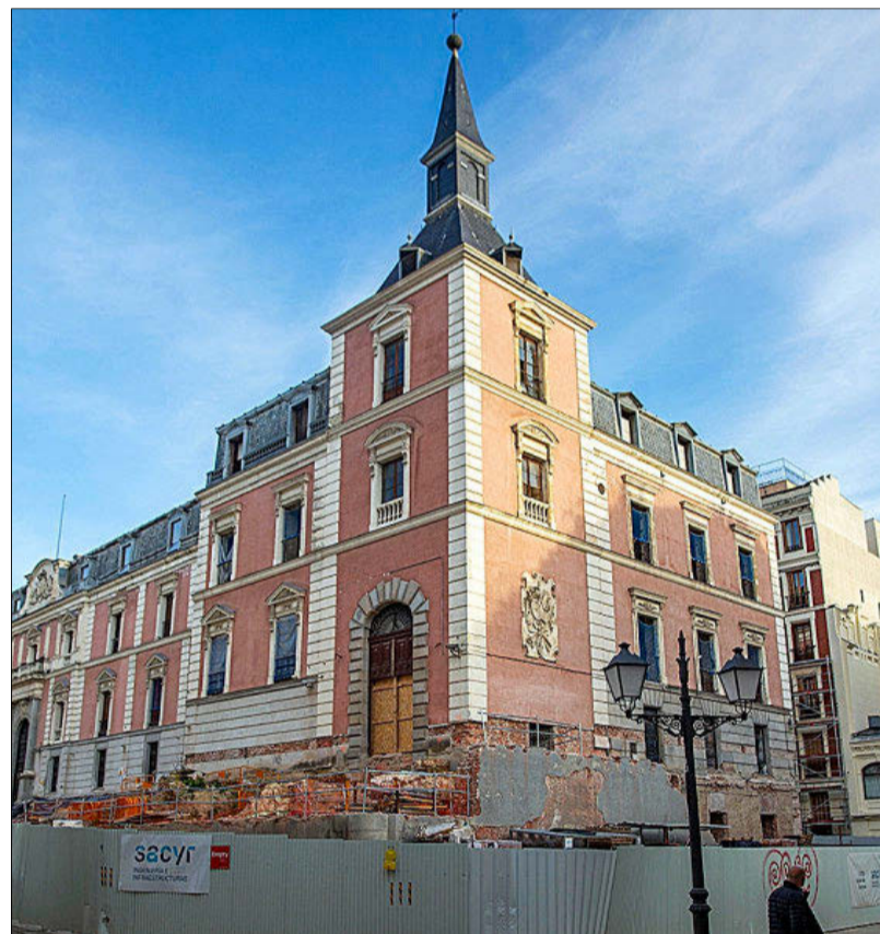
La calle de Méndez Núñez, en obras, con el Salón de Reinos al fondo. FELIPE DÍAZ DE VIVAR
