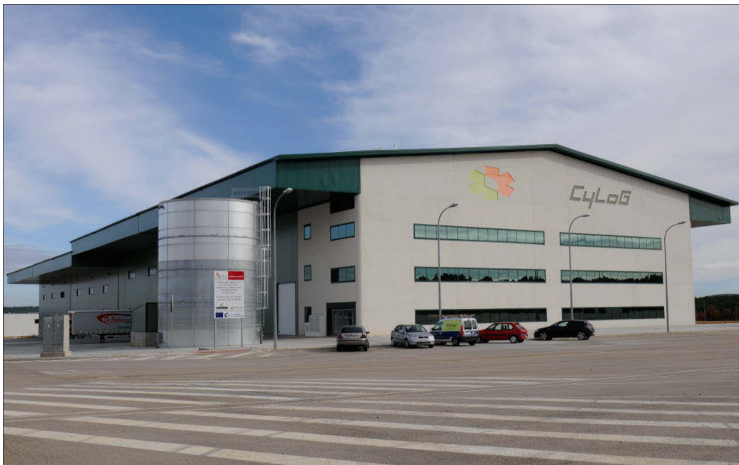
Instalaciones del antiguo Cylog en Navalcaballo. HDS
